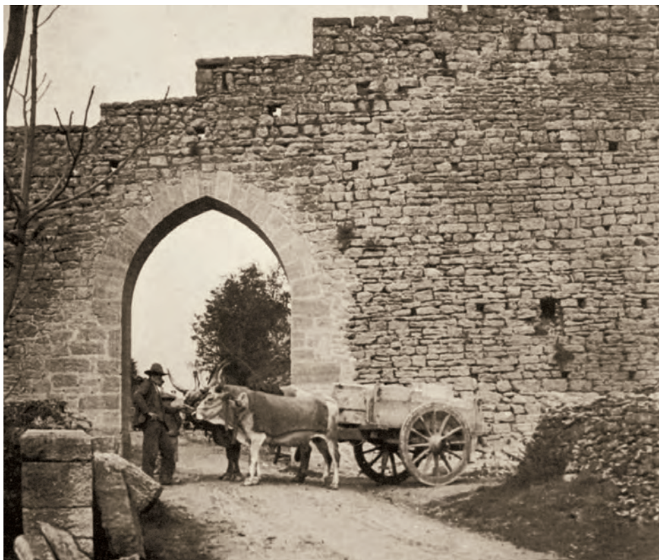
Un carro agricolo alla Porta della Fratta. Trasporta pietra lavorata, prelevata dalla Cava Antica, la più ricca di ottima pietra, che per secoli ha fornito materiale per i lavori del Paese.
